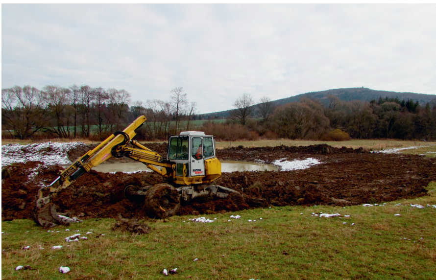
Tůň v nivě řeky Blanice byla obnovena z iniciativy hospodářícího zemědělce.
